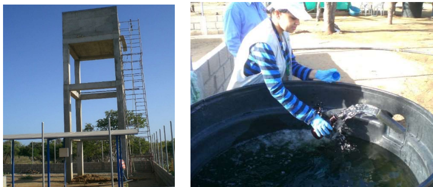
Figura 20. Tanque elevado y toma de muestra de agua pozo profundo, Comunidad Amaichon.
