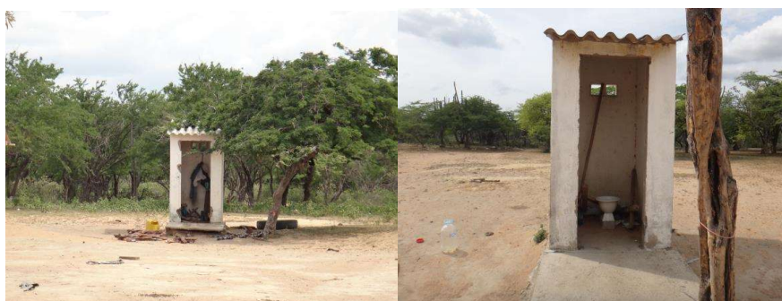
Figura 16. Baterías sanitarias en área de estudio
