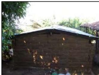
Fig. 58. Vivienda de adobe dañada por sismos en Cantón Montañaíta en Alegría.
