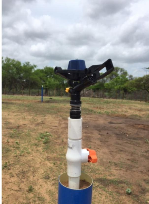
Foto 93. Instalación de redes de riego por goteo y aspersores.
