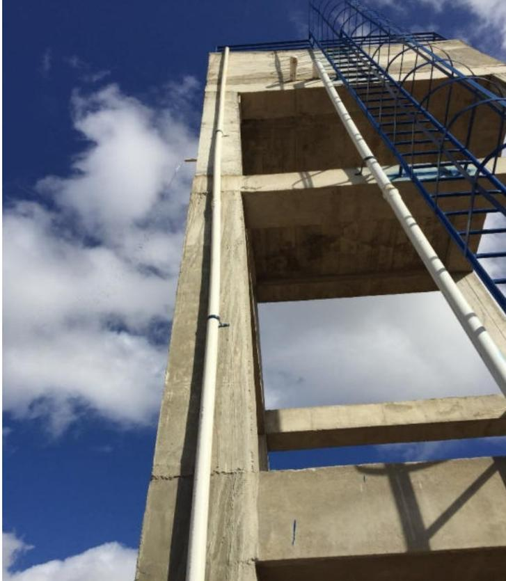
Foto 56. Instalación y la conexión de la red hidráulica del tanque en tubería de 2" y accesorios
