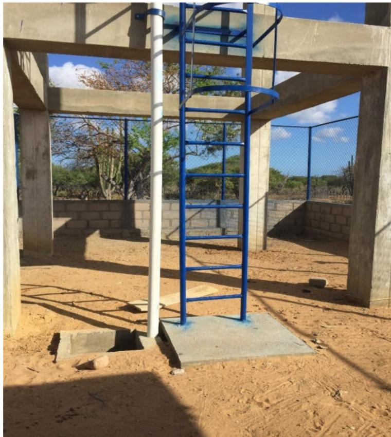
Foto 61. Conexión de la red de hidráulica del tanque con la red de distribución principal en 3”.
