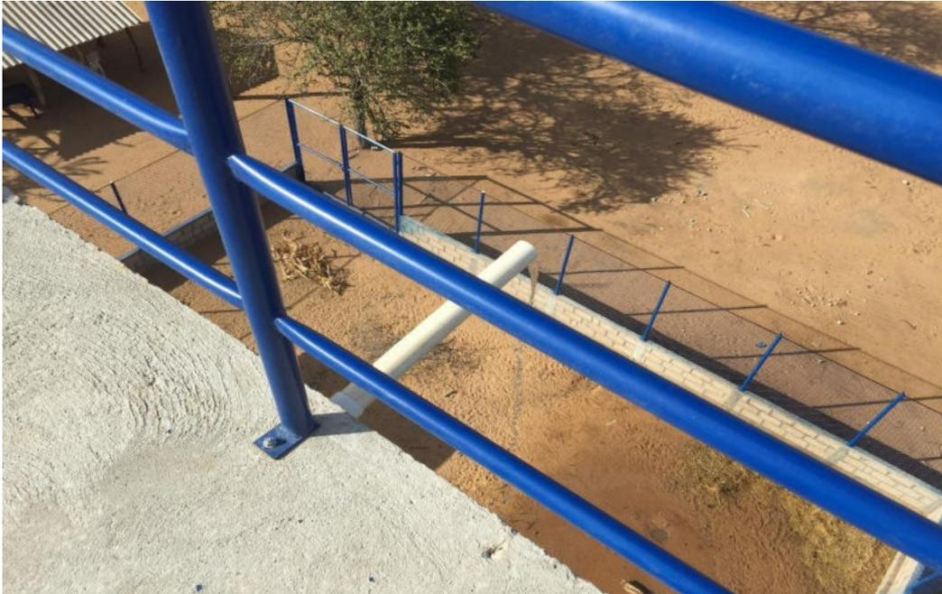
Foto 58. Tubería de rebose de tanque para descargue en terreno natural.
