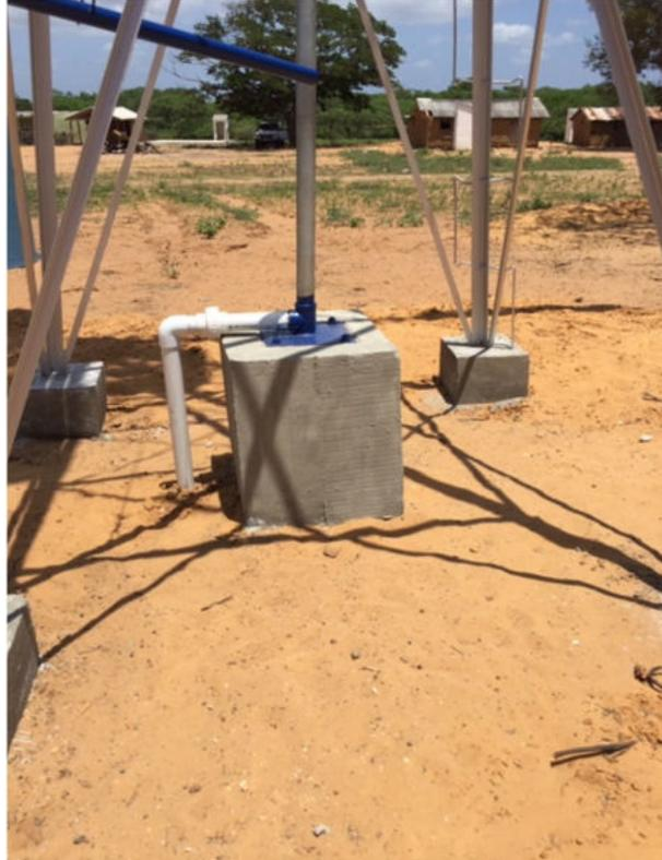
Foto 110. Fundida de sello del pozo y conexión de tubería de 2" para extracción de agua por medio del molino sector Amuruluba.
