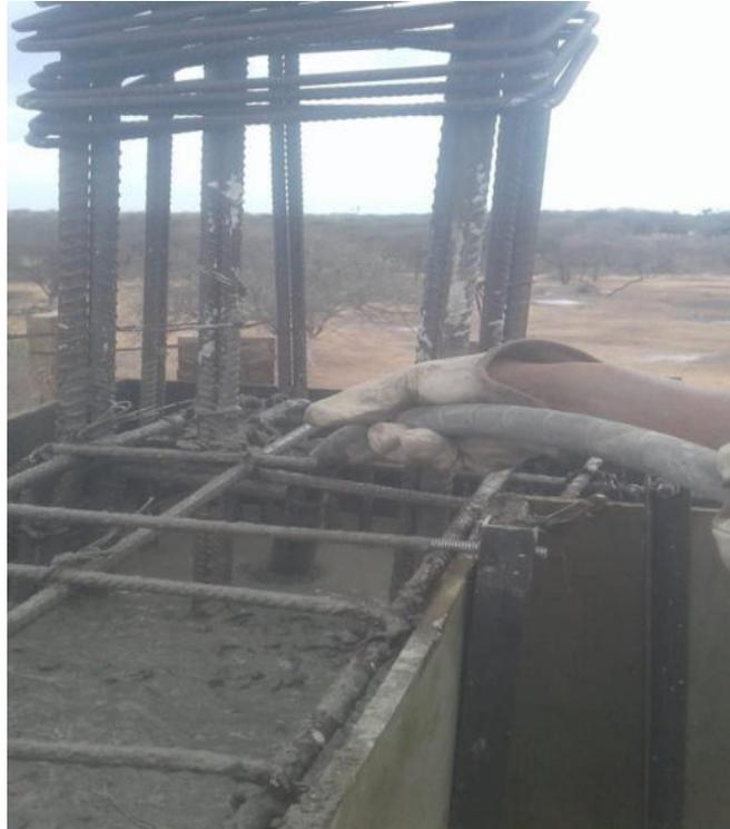
Foto 29. Vibrado de concreto en elementos estructurales (vigas aéreas nivel 1)
