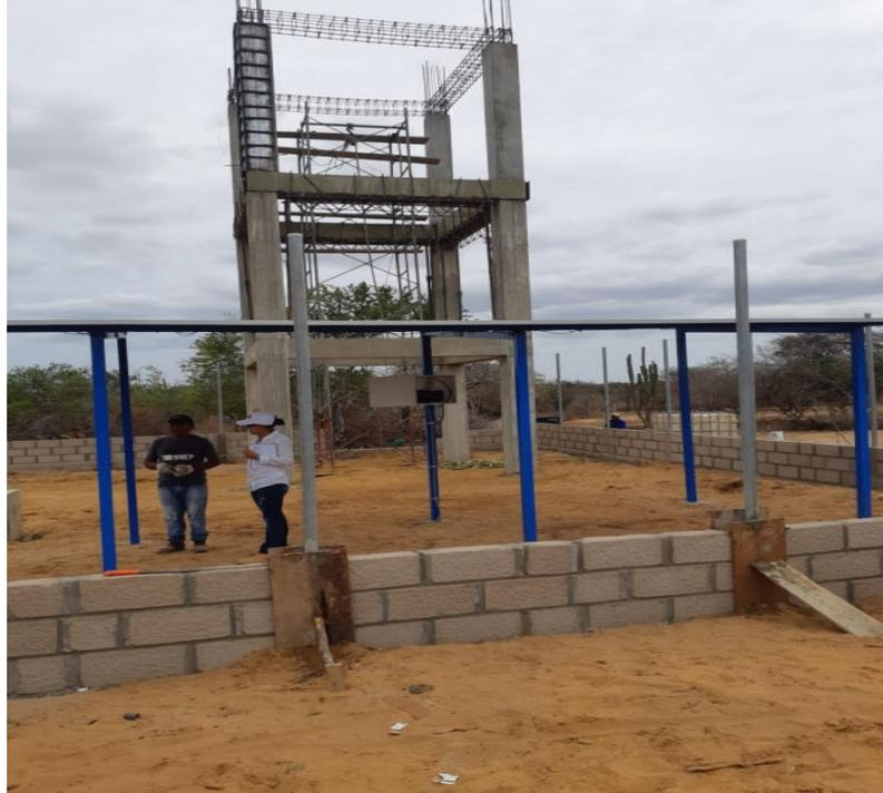
Foto 33. Armado de acero, encofrado y fundida de columnas nivel 3 (9m)
