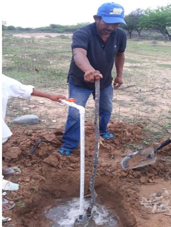
Foto 71. Instalación y conexión puntos domiciliarios 1/2"
