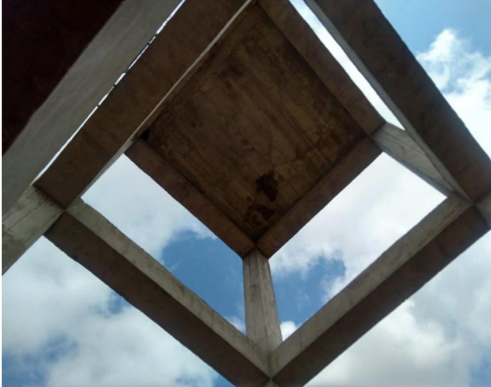
Foto 64 Tanque elevado en funcionamiento, no presenta filtraciones
