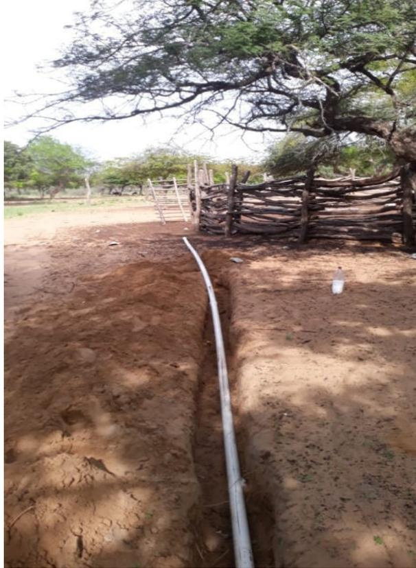
Foto 68. Instalación de tubería 2"
