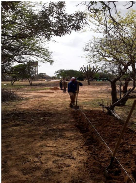
Foto 66. Excavaciones para instalación de tubería.
