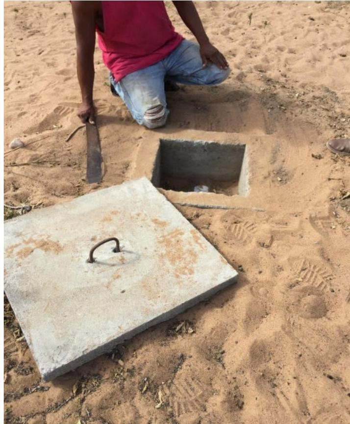
Foto 76. Construcción de cajas y tapas para las válvulas (0.6mt X 0.6mt), instalación y conexión de las válvulas de registro
