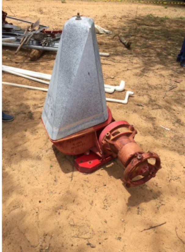
Foto 105. Desmonte de estructura del molino existente para mantenimiento sector Amuruluba.
