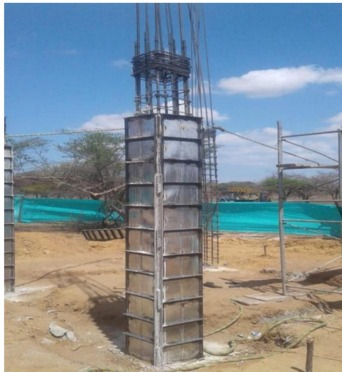
Foto 26. Encofrado para fundida de elementos estructurales (columnas nivel 1)
