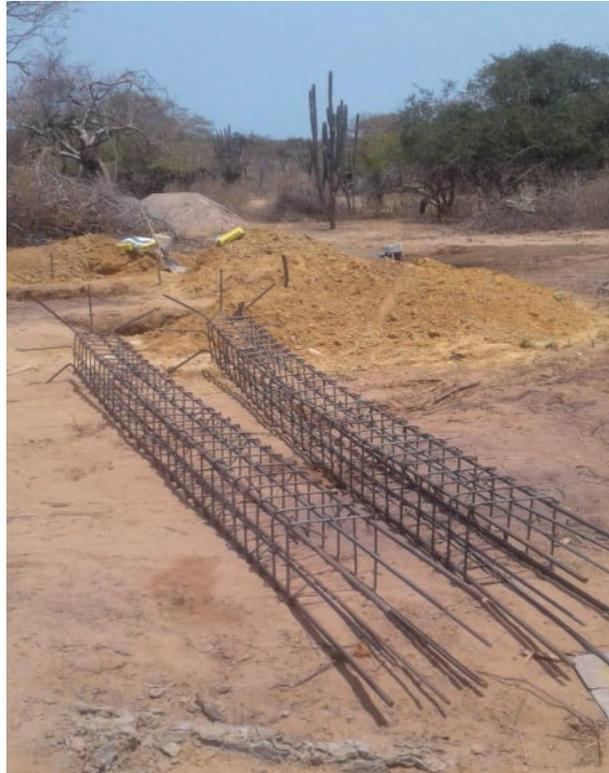
Foto 19. Figuración de acero arranques de elementos estructurales (columnas).
