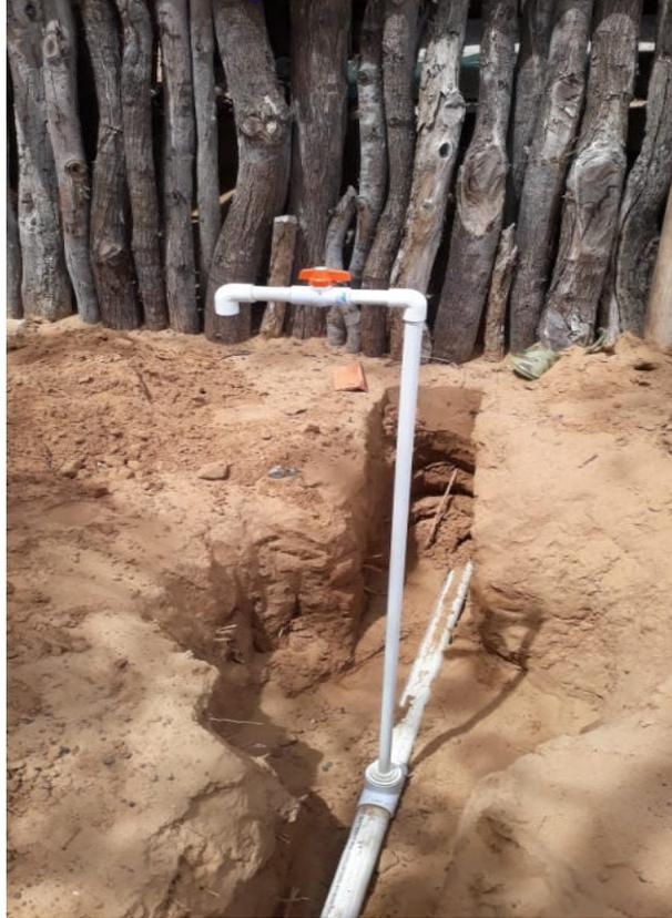
Foto 69. Reducciones de tubería de 2" a 1/2" para puntos domiciliarios.
