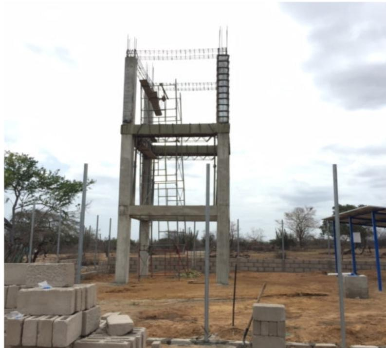
Foto 34. Armado de acero de vigas aereas nivel 3 (9m)
