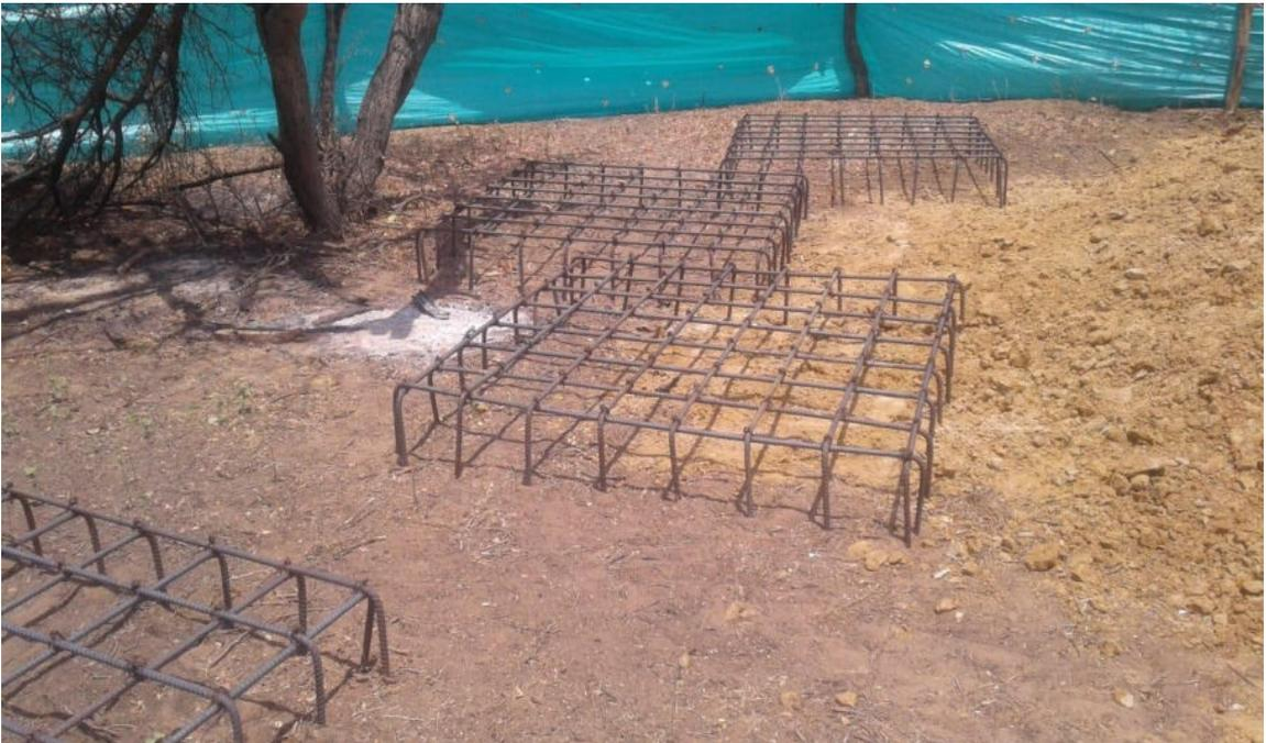
Foto 18. Figuración de acero para elementos de cimentación (zapatas).
