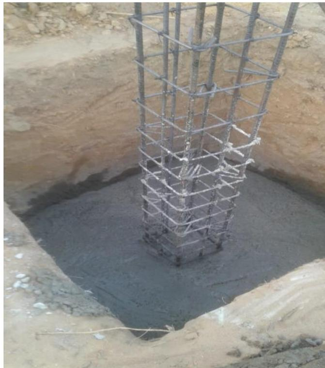
Foto 22. Fundida en concreto de elementos de cimentación (zapatas).
