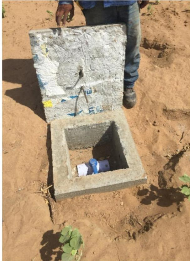
Foto 72. Instalación de válvulas y construcción de cajas de registro.
