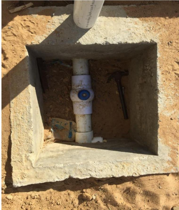
Foto 59. Conexión de la red de hidráulica del tanque con la red de distribución principal en 3".
