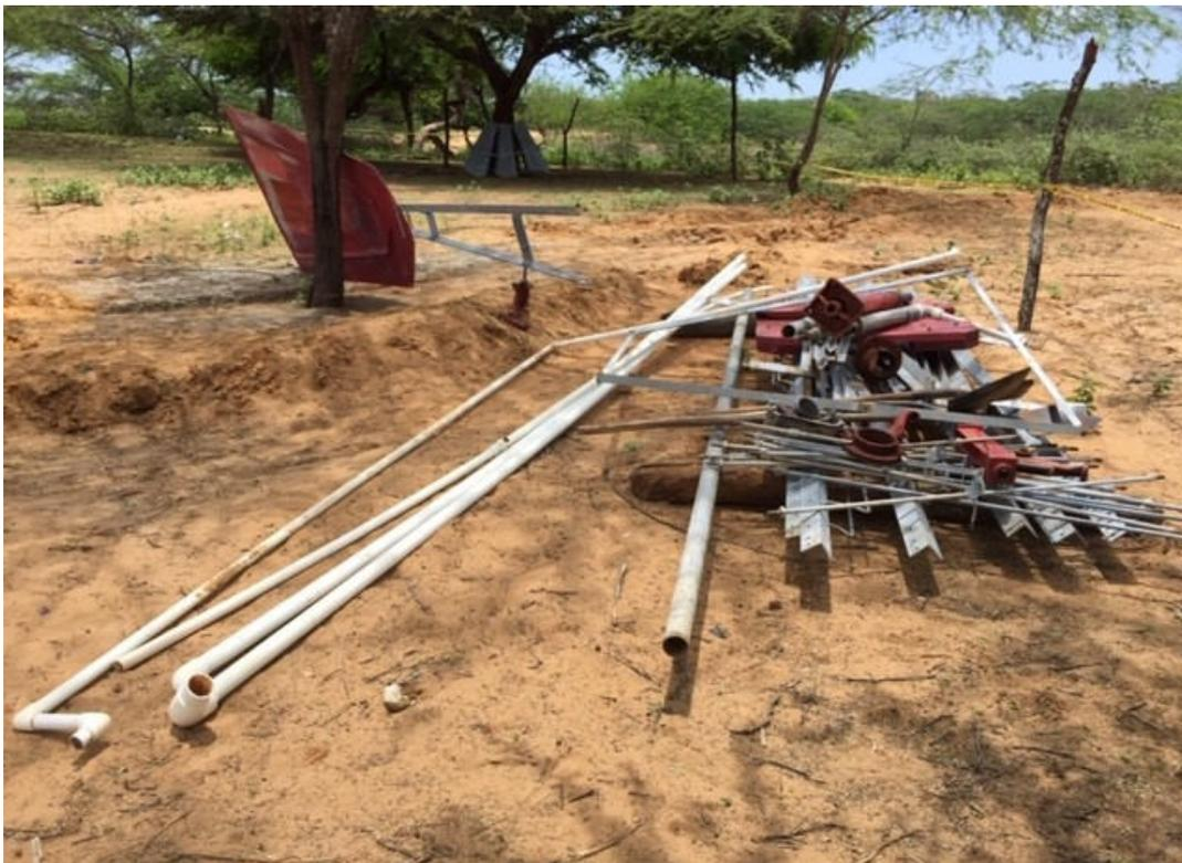
Foto 104. Desmonte de molino existente para mantenimiento sector Amuruluba.
