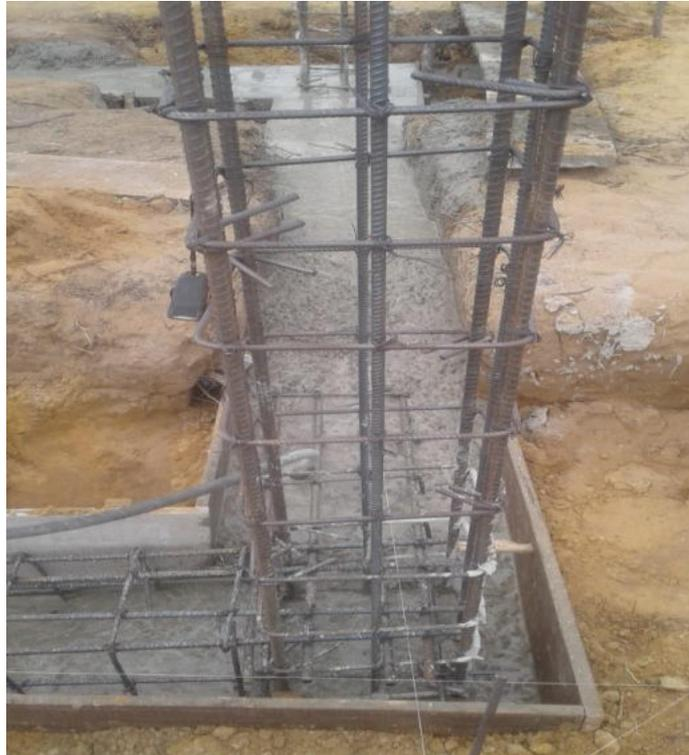
Foto 25. Fundida en concreto de elementos de cimentación (vigas)
