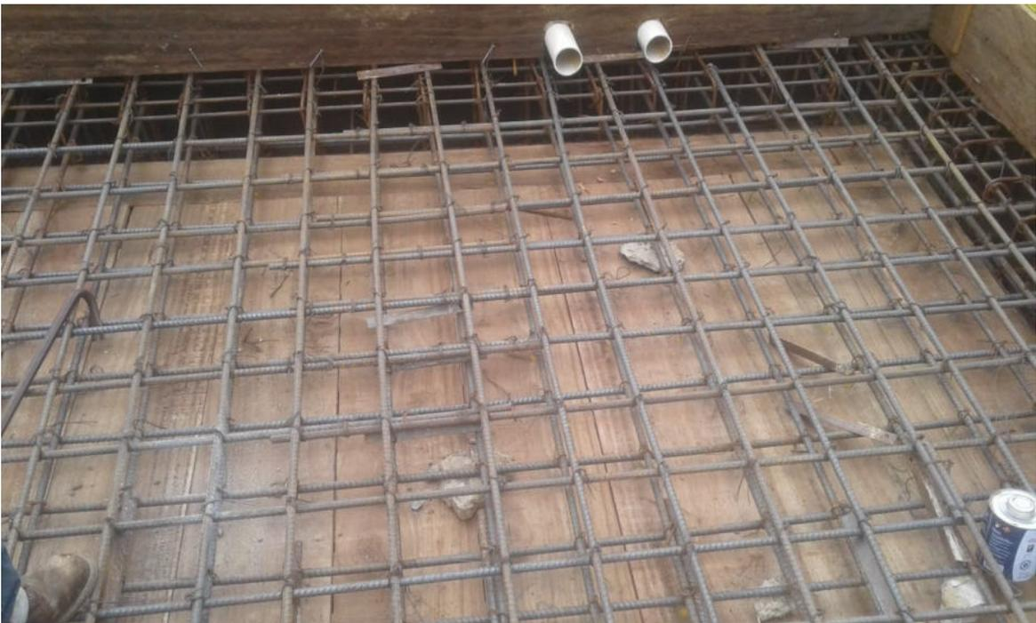
Foto 38. Armado de acero losa inferior para fundida de losa inferior de tanque.
