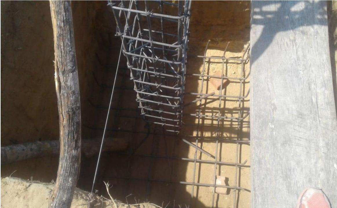
Foto 21. Armado de acero de elementos estructurales (zapatas y columnas).
