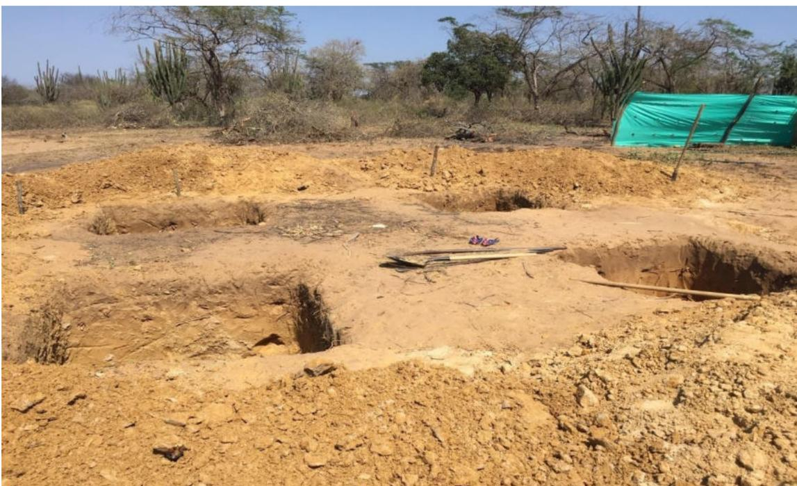
Foto 16. Labores de excavación para elementos de cimentación (zapatas).
