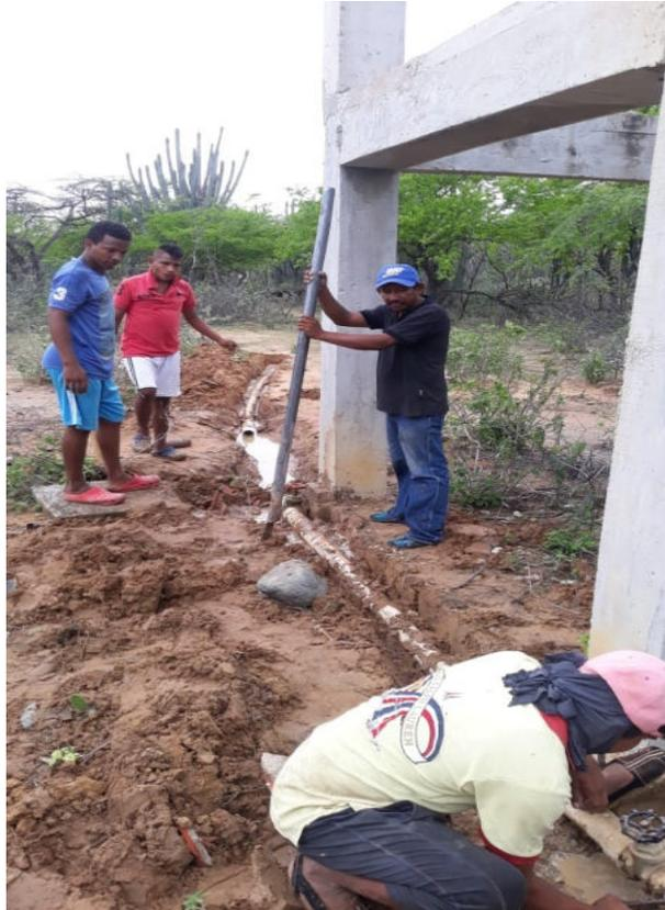
Foto 73. Revisión de red hidráulica existente en 2".
