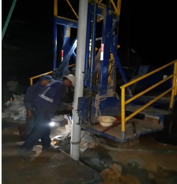
Foto 9. Proceso instalación de tubería de 6" PVC RDE 21.
