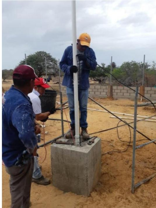
Foto 11. Proceso instalación de electro bomba sumergible con tubería de conducción 2".
