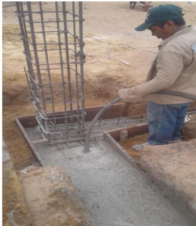
Foto 24. Vibrado de concreto para elementos de cimentación (vigas).
