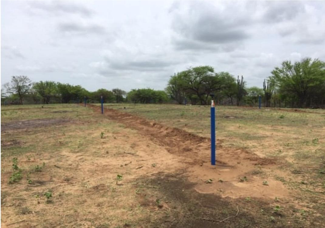
Foto 91. Instalación de puntos de riego con aspersores.
