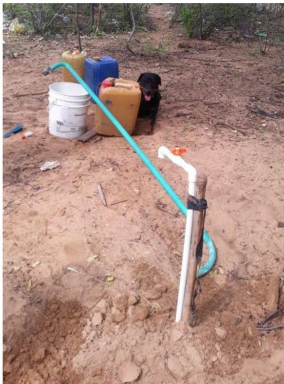
Foto 74. Instalación y prueba de los puntos domiciliarios de ½" con las llaves de cierre
