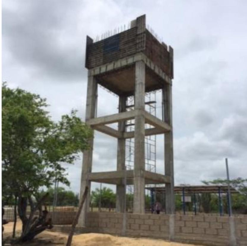
Foto 44. Encofrado para muros de tanque
