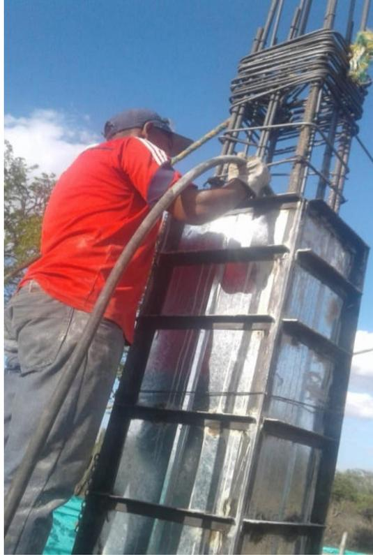
Foto 27. Vibrado de concreto en elementos estructurales (columnas nivel 1)
