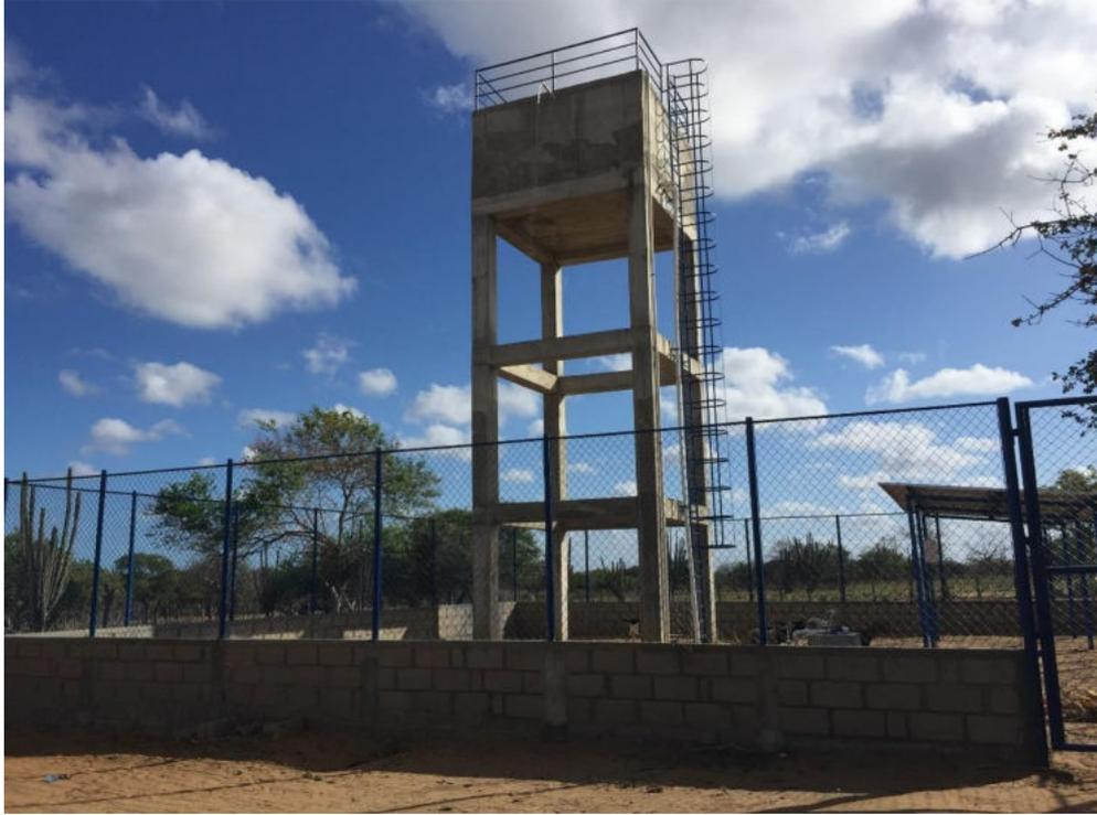
Foto 55. Malla eslabonada para cerramiento y portón en malla eslabonada.
