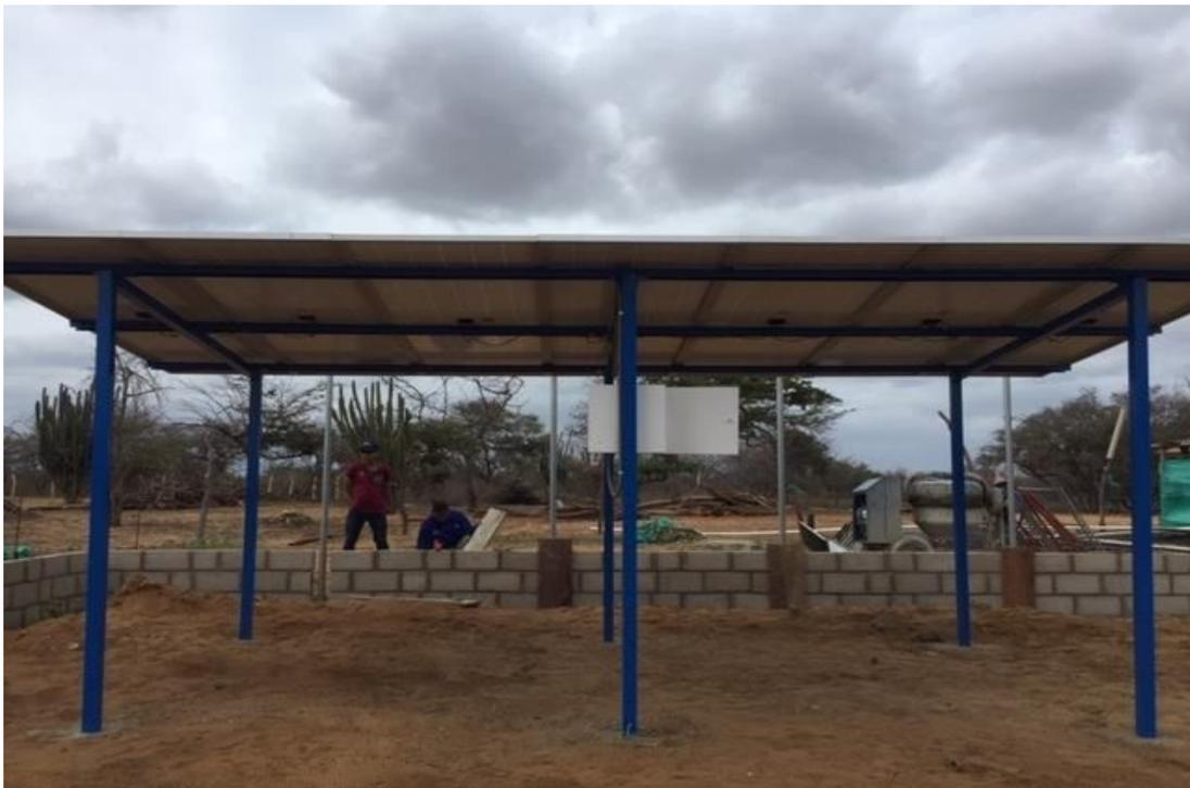
Foto 12. Instalación de perfilaría metálica, paneles solares, red eléctrica e hidráulica para sistema de bombeo.
