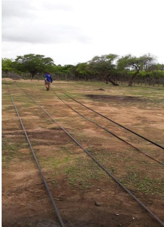
Foto 89. Instalación de cinta para red de riego por goteo.
