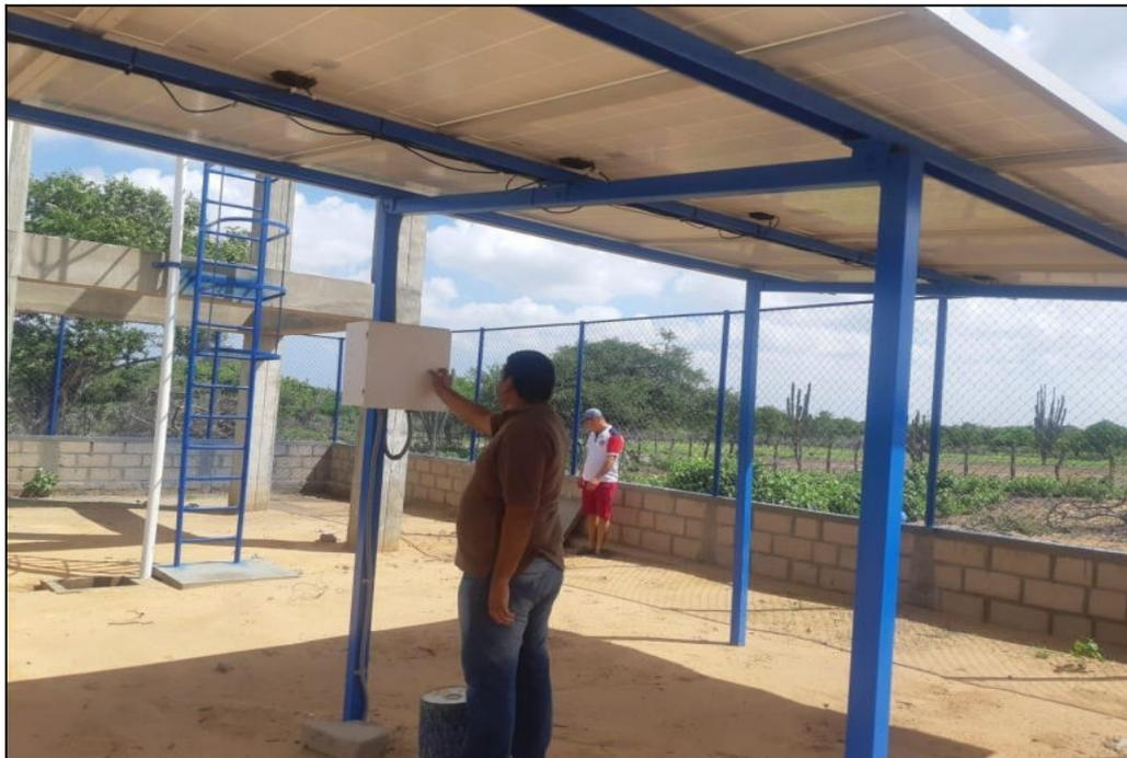
Foto 78. Suministro e instalación de sistema de bombeo solar directo.
