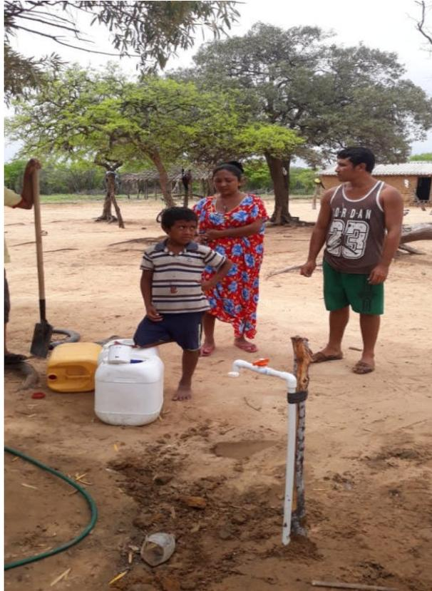
Foto 70. Instalación y conexión puntos domiciliarios 1/2"
