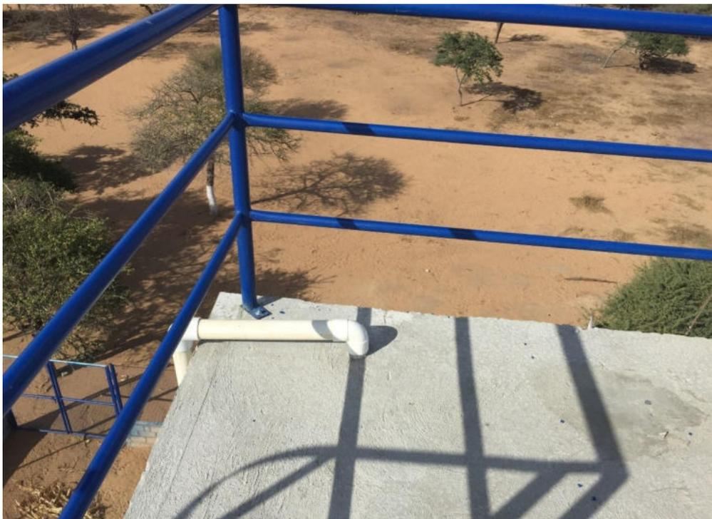
Foto 57. Conexión de la red hidráulica del tanque en tubería de 2".
