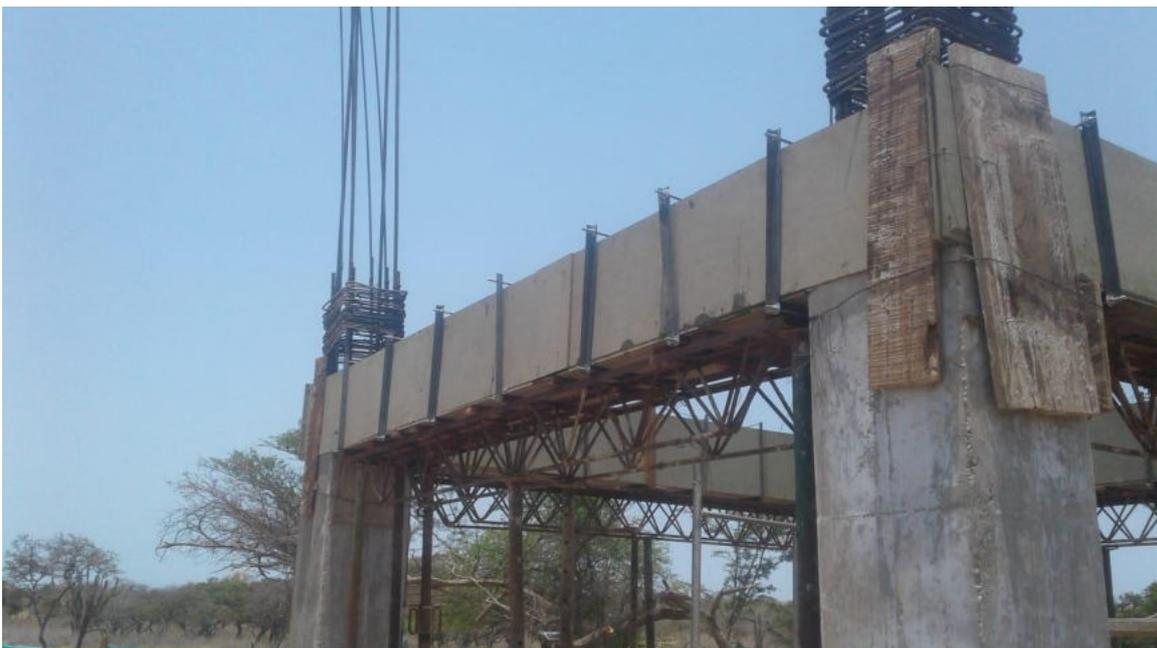
Foto 28. Encofrado para fundida de elementos estructurales (vigas aéreas nivel 1)
