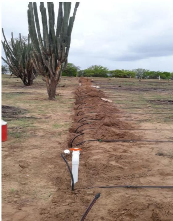
Foto 88. Instalación de cinta para red de riego por goteo.
