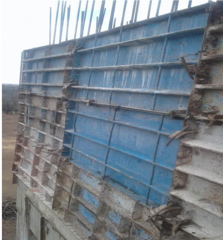
Foto 43. Encofrado exterior de muros para fundida de tanque.
