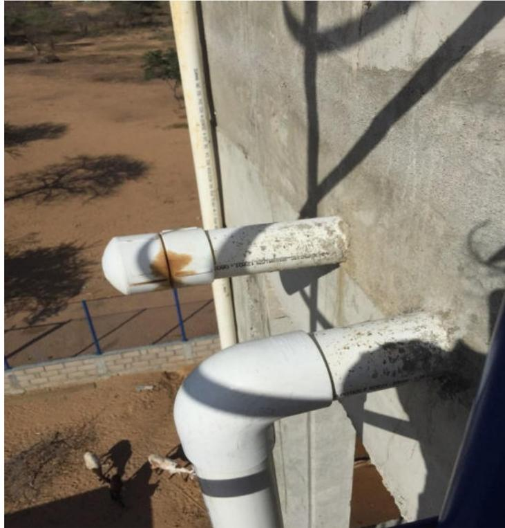
Foto 62. Instalación de tubería para lavado de tanque.
