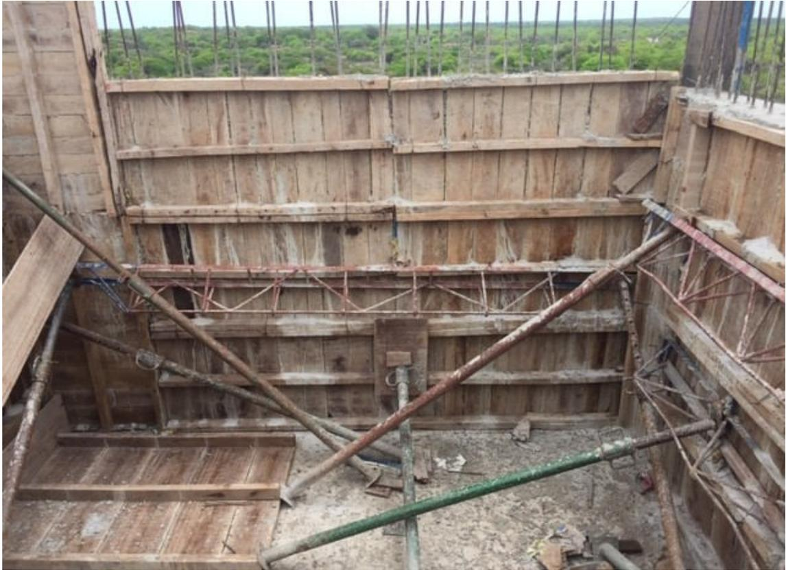
Foto 45. Encofrado interior para muros de tanque
