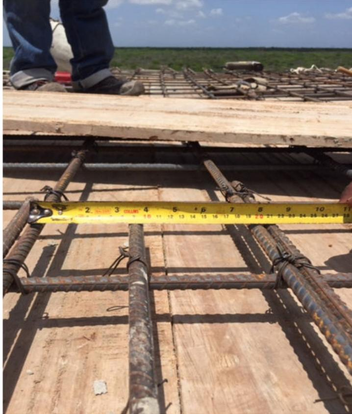
Foto 50. Figuración y armado de aceros de refuerzo de la losa superior del tanque
