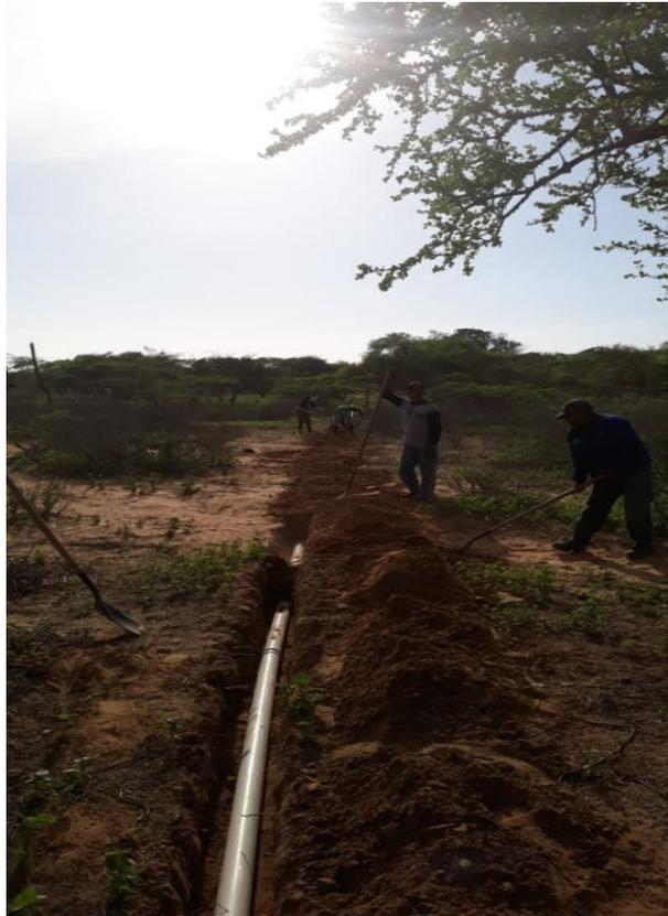
Foto 67. Instalación de tubería 3"
