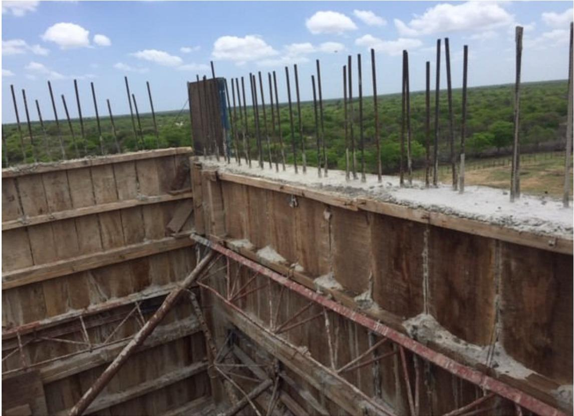
Foto 46. Fundida en concreto de muros de tanque.
