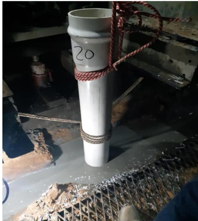
Foto 10. Proceso instalación de tubería de 6" PVC RDE 21.
