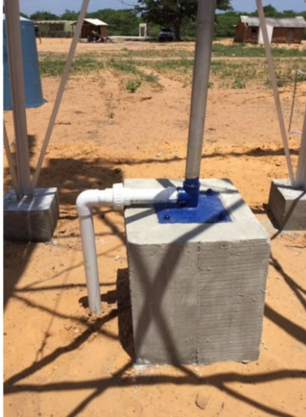
Foto 109. Fundida de sello del pozo y conexión de tubería de 2" para extracción de agua por medio del molino sector Amuruluba.
