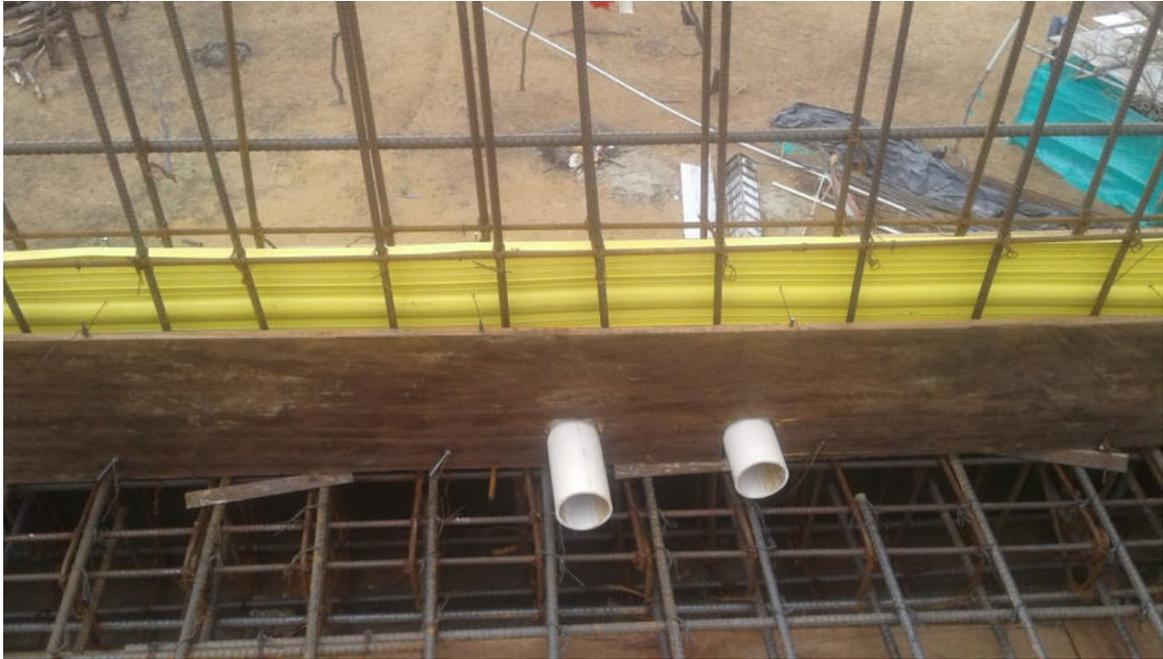
Foto 39. Detalle de Instalacion de cinta PVC para junta de construccion y sección de tubos para evacuación de agua.
