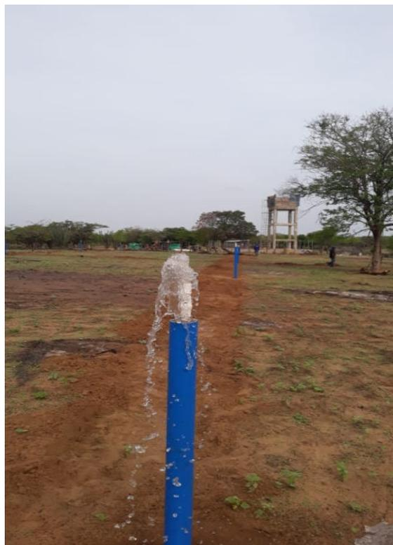
Foto 90. Instalación de puntos de riego con aspersores.
