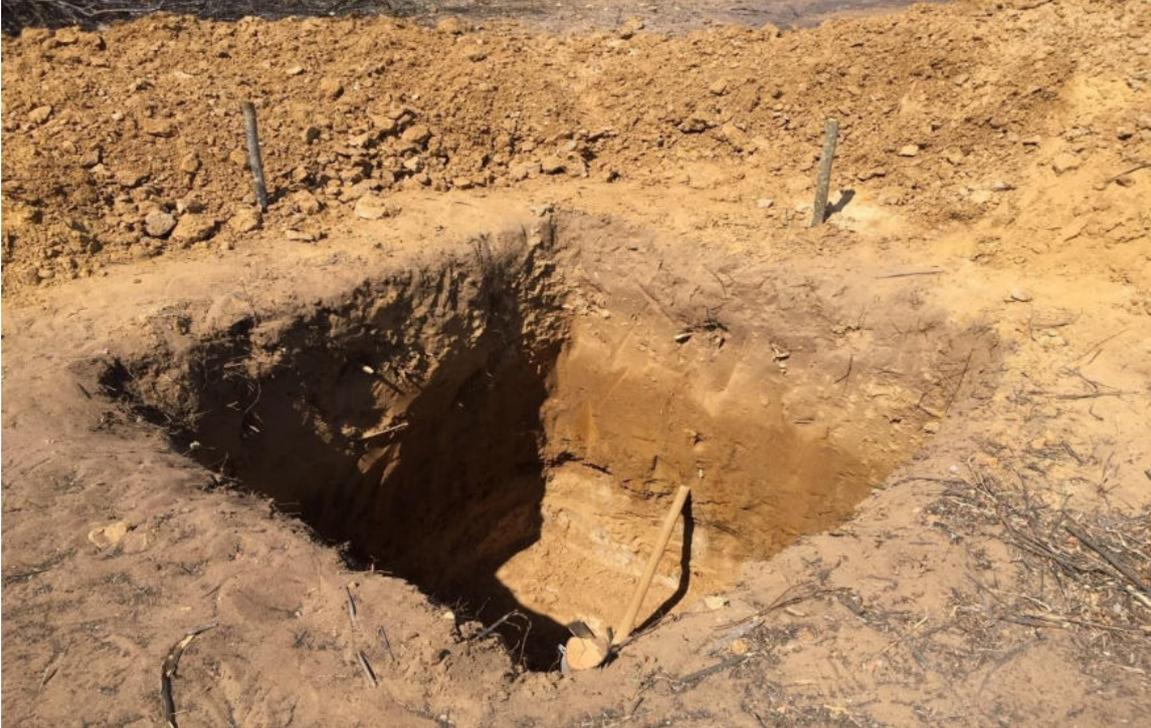
Foto 17. Labores de excavación para elementos de cimentación (zapatas).
