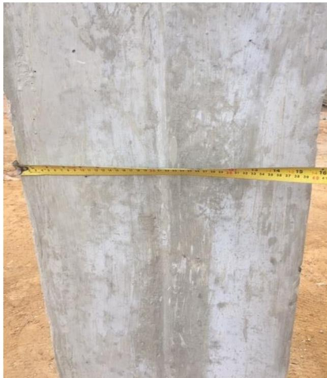
Foto 32. Verificación de medidas de elementos estructurales.
