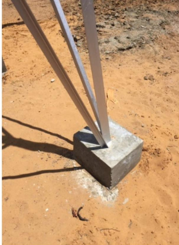
Foto 108. Fundida de bases para estructura del molino sector Amuruluba.
