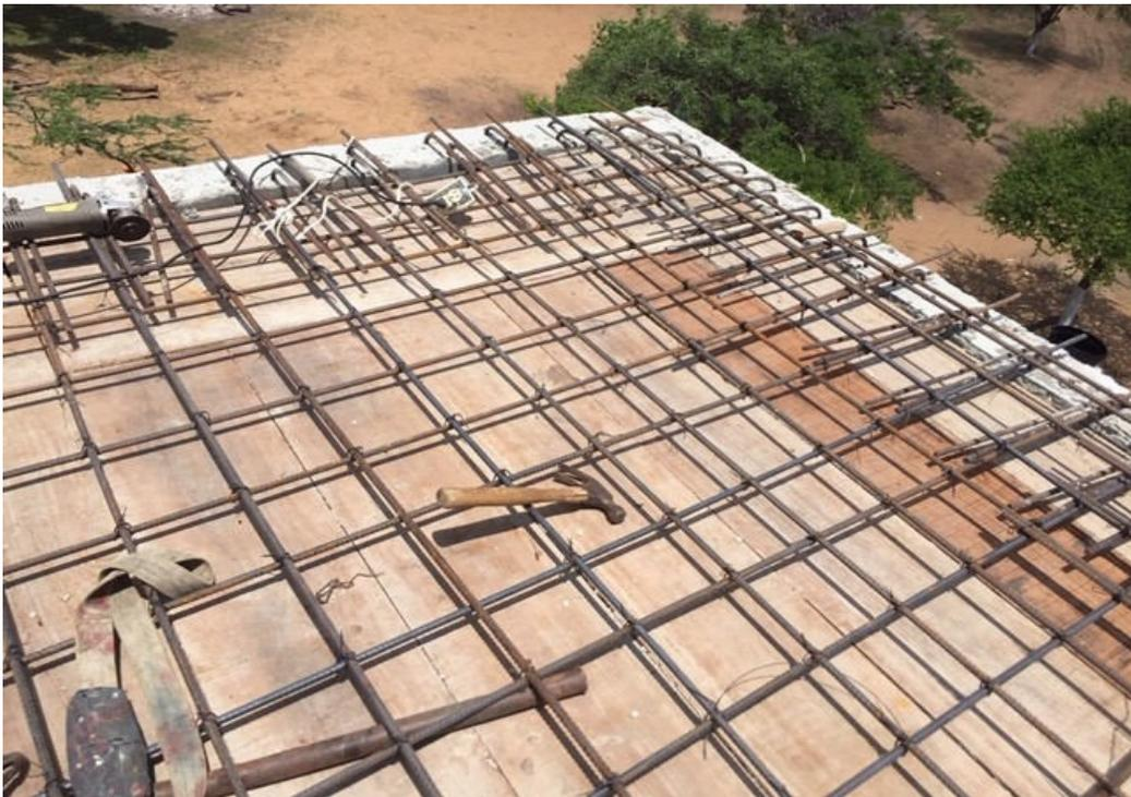
Foto 49. Encofrado, configuración y armado de aceros de refuerzo de la losa superior del tanque.
