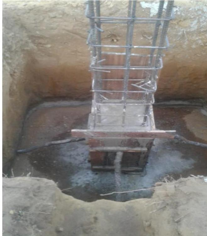
Foto 23. Fundida en concreto de elementos de cimentación (pedestales).
