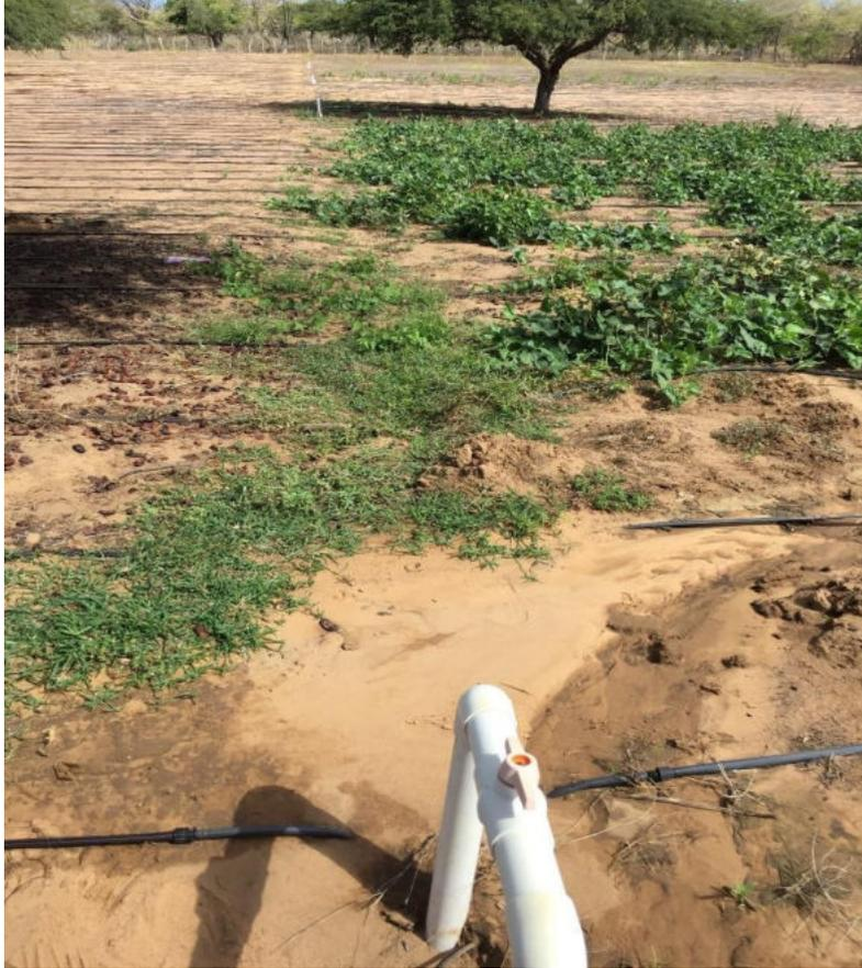
Foto 97. Instalación de puentes con válvulas de paso Granja No 3.
