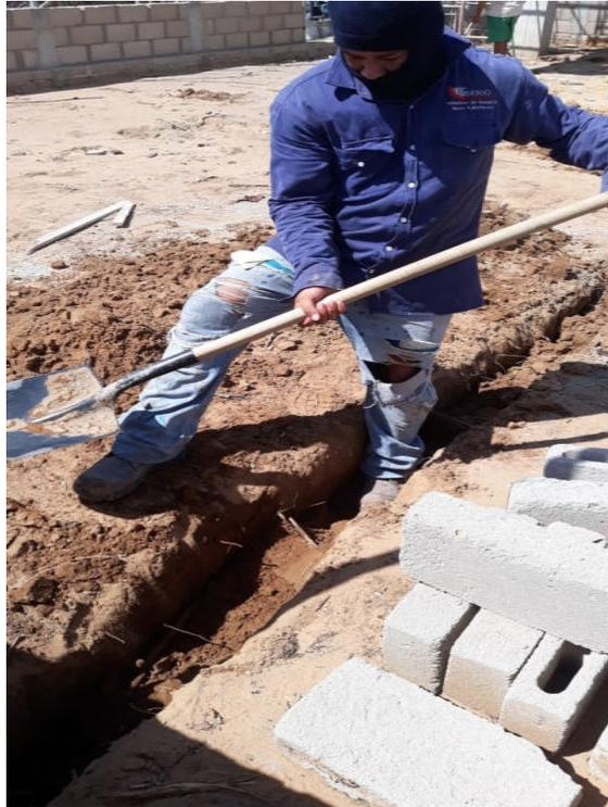
Foto 65. Excavaciones para instalación de tubería.
