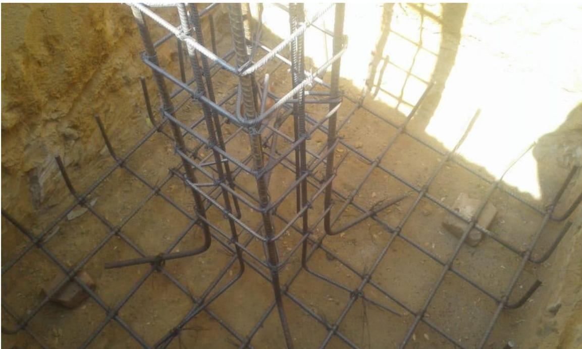
Foto 20. Armado de acero de elementos estructurales (zapatas y columnas).
