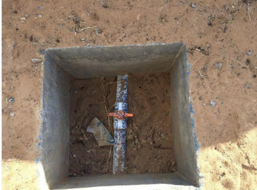
Foto 75. Construcción de cajas y tapas para las válvulas (0.6mt X 0.6mt) e Instalacion y conexion de las válvulas de registro.
