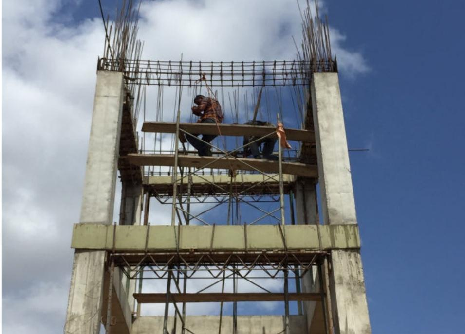
Foto 35. Armado de acero de vigas aereas nivel 3 (9m)
