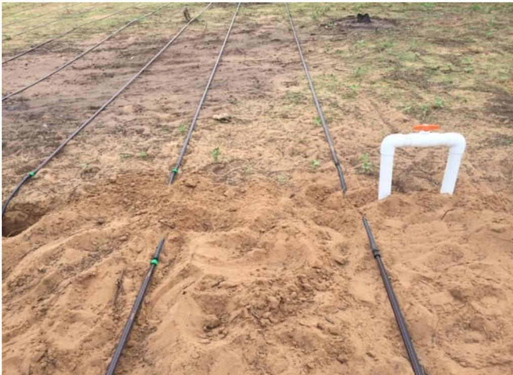
Foto 94. Instalación puentes con llave de paso para control de riego
