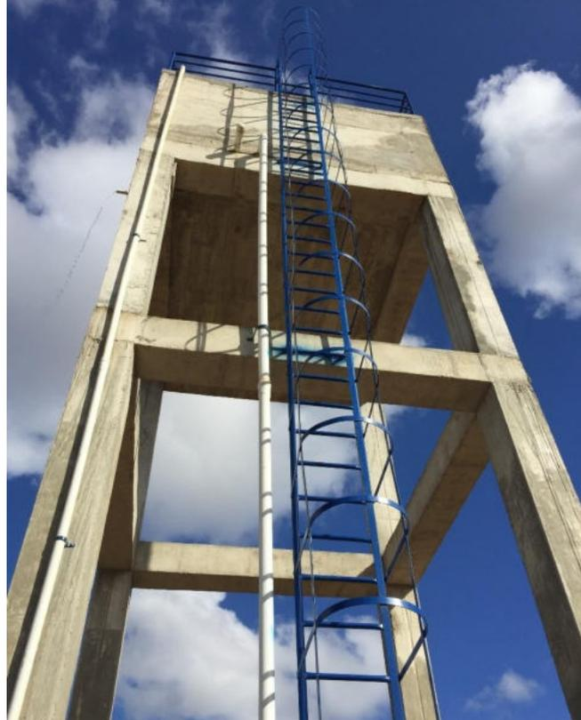
Foto 53. Escalera metálica exterior para acceso a losa superior
