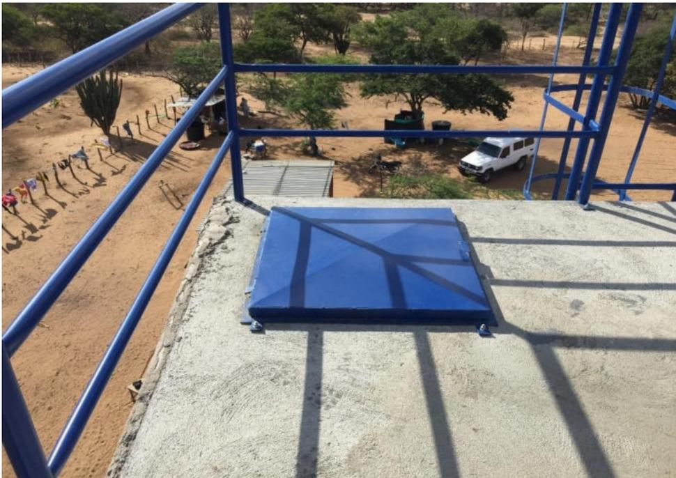
Foto 52. Tapa metálica para acceso interno al tanque
