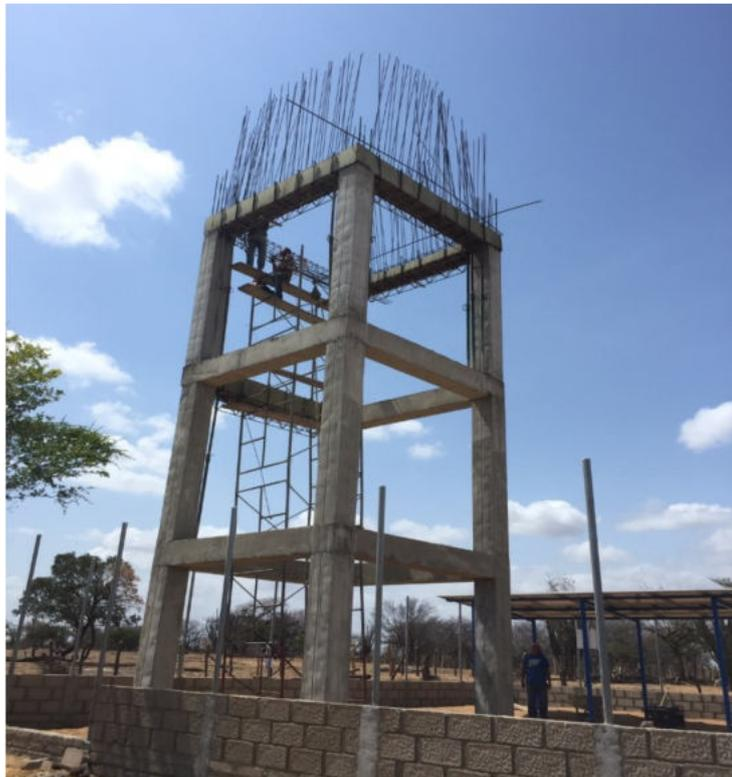
Foto 36. Encofrado de vigas aereas nivel 3 (9m) e instalacion de acero de arranque para muros de tanque.
