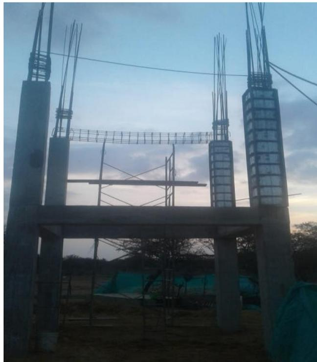
Foto 30. Encofrado y fundida de elementos estructurales (columnas nivel 2)
