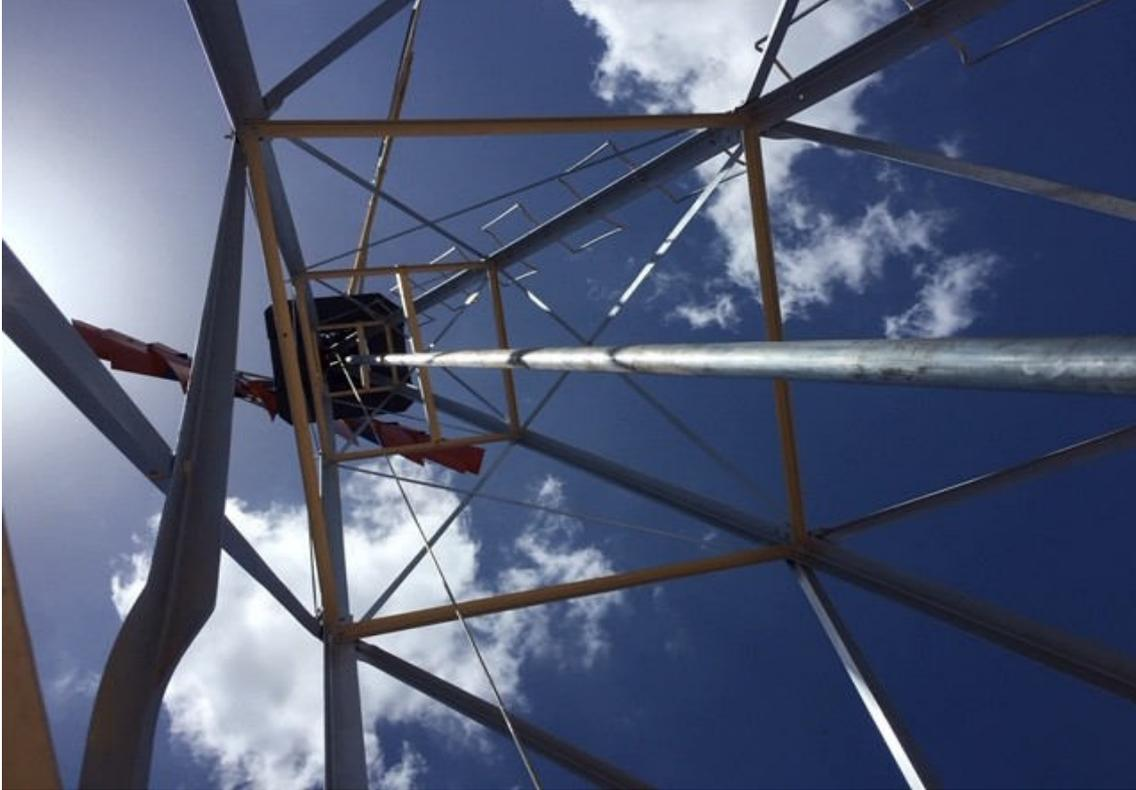
Foto 111. Aplicación de pintura anticorrosiva y armado de estructura del molino. Conexión de tubería de 2" para extracción de agua sector Amuruluba.
