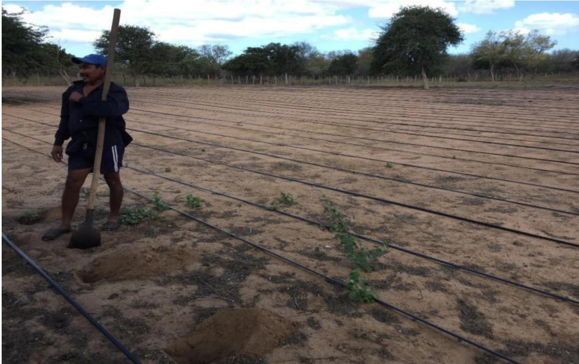
Foto 96. Instalación de la red para riego por goteo granja No 3.
