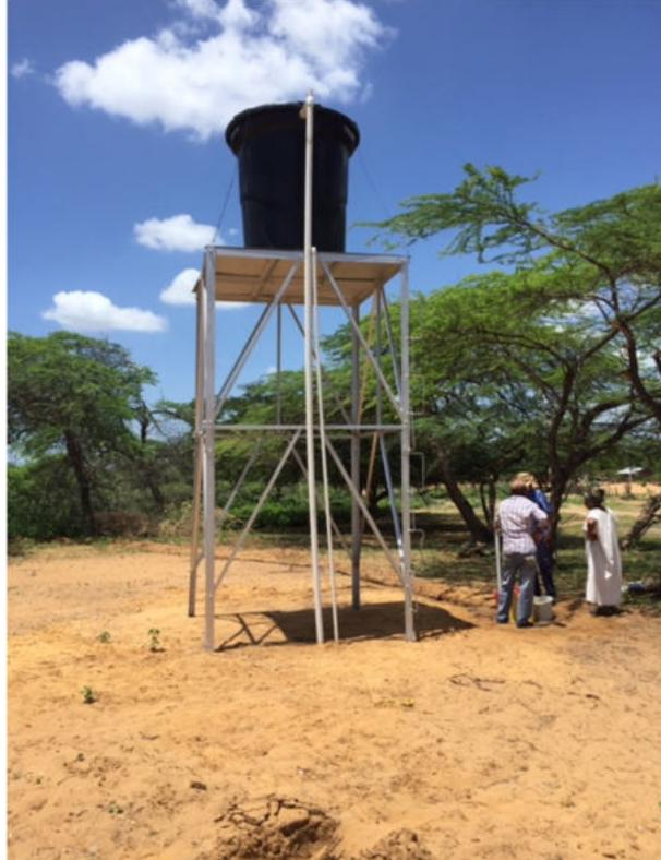
Foto 112. Aplicación de pintura anticorrosiva y armado de estructura para base de tanque almacenamiento de 2000 lts, conexión de red de llenado de tanque en 2" y red distribución en tubería de 1" hasta punto provisional sector Amuruluba.
