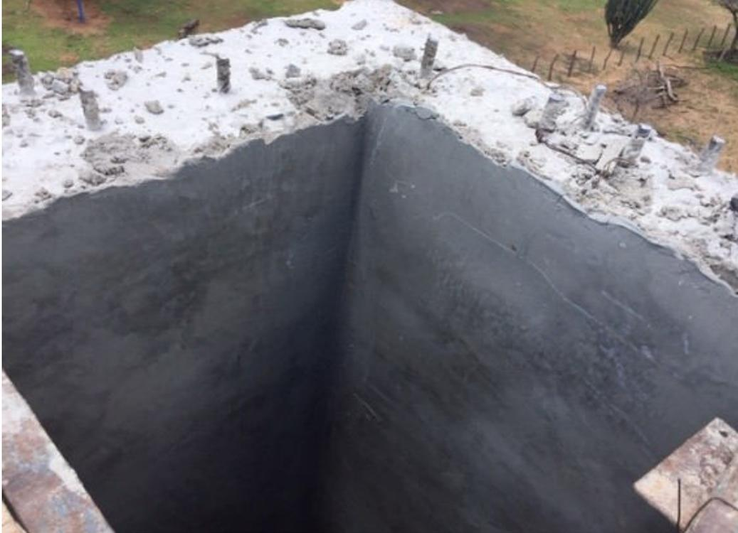
Foto 48. Aplicación de pañete pulido en paredes interiores de tanque.
