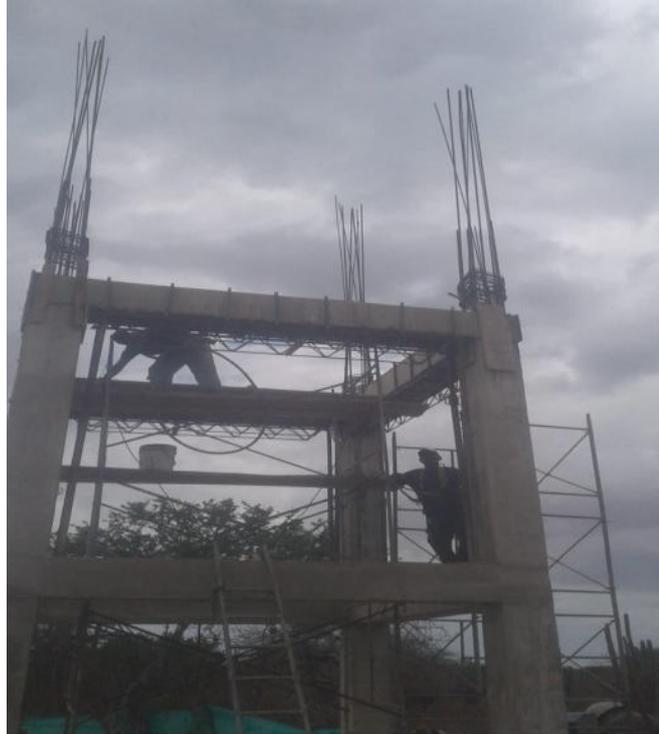
Foto 31. Encofrado y fundida de elementos estructurales (vigas aéreas nivel 2)
