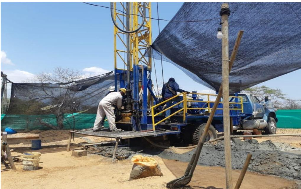
Foto 6. Proceso de perforación de pozo.
