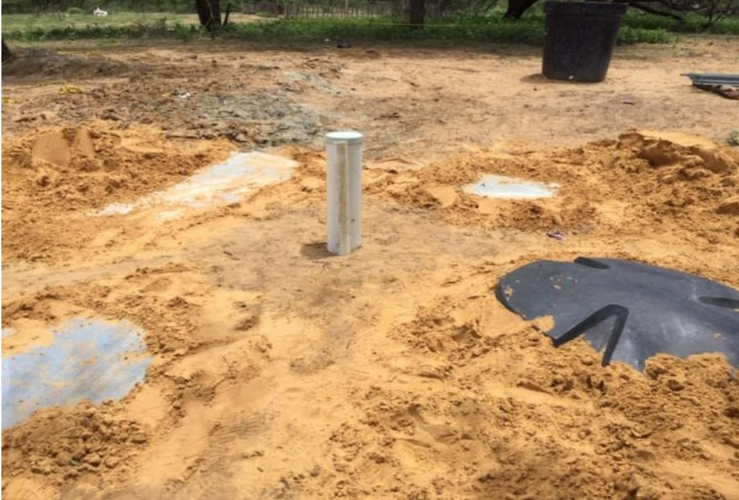
Foto 103. Perforación e instalación de tubería para pozo profundo Amuruluba. Excavación de bases para molino.
