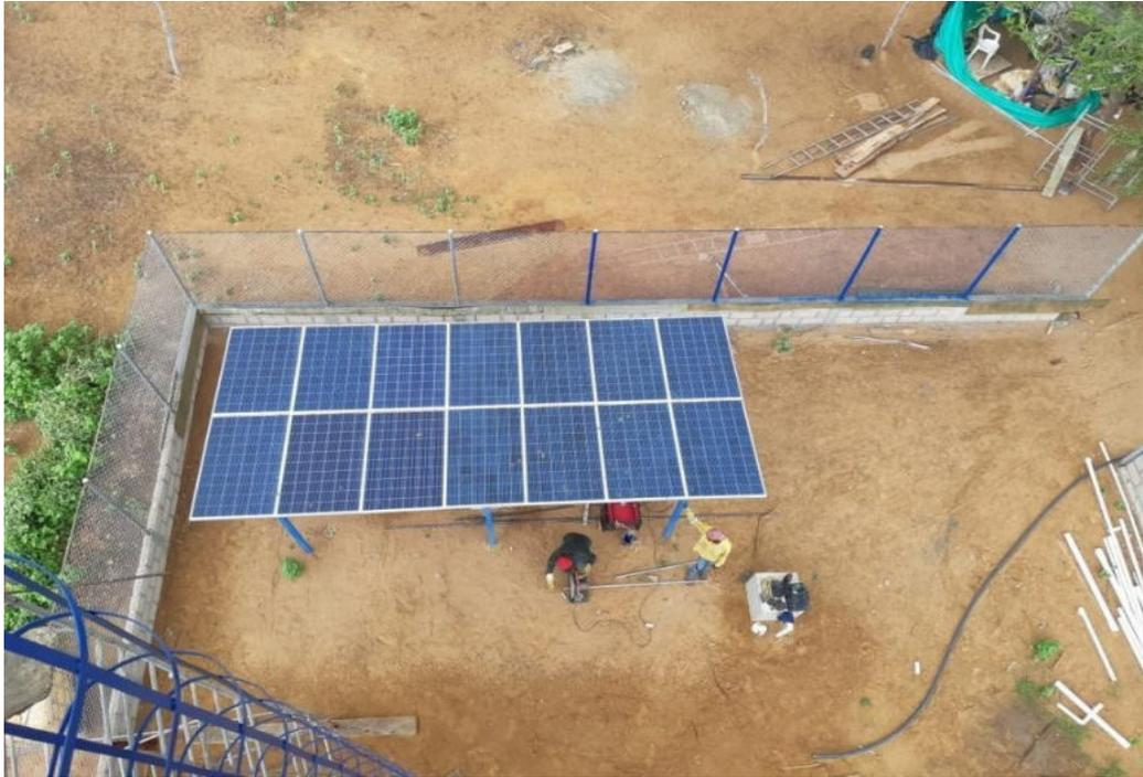
Foto 77. Suministro de paneles solares y cerramiento con malla eslabonada
