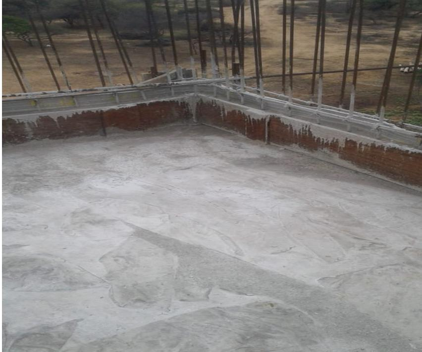
Foto 41. Fundida de losa inferior de tanque.
