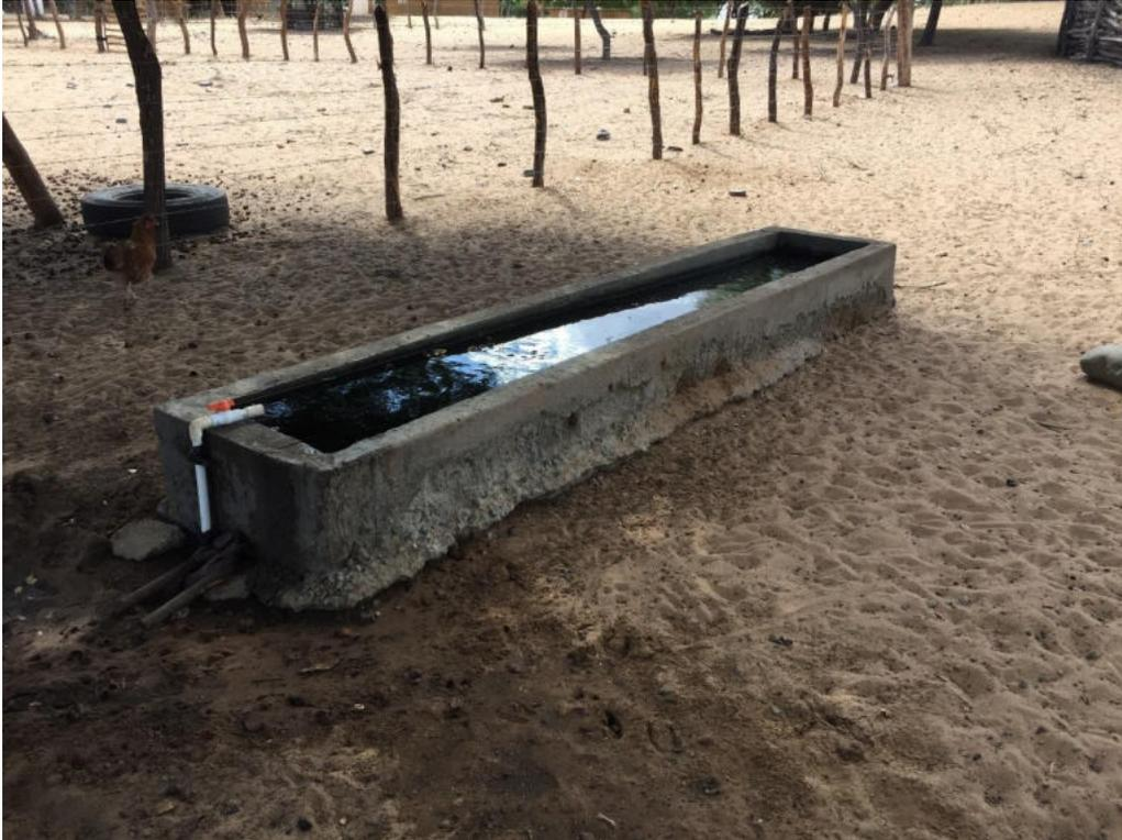
Foto 101. Instalación de tubería y punto para suministro en bebederos en 1" con llave de control.
