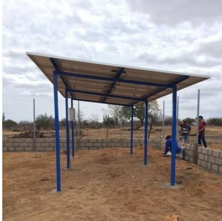
Foto 13. Instalación de perfilería metálica, paneles solares, red eléctrica e hidráulica para sistema de bombeo.
