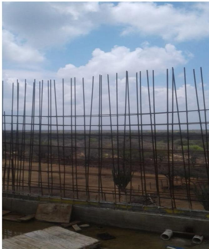
Foto 42. Armado de acero para muros de tanque.
