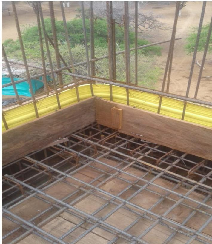
Foto 40. Detalle de instalacion de cinta PVC para junta de construccion
